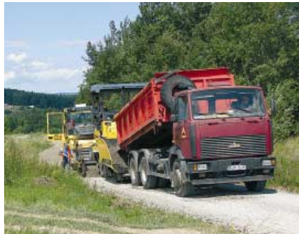
Droga Rzepiennik Biskupi w kierunku P. Kafla - układanie podbudowy
