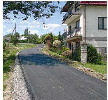
Droga Turza - Zalesie warstwa asfaltu
