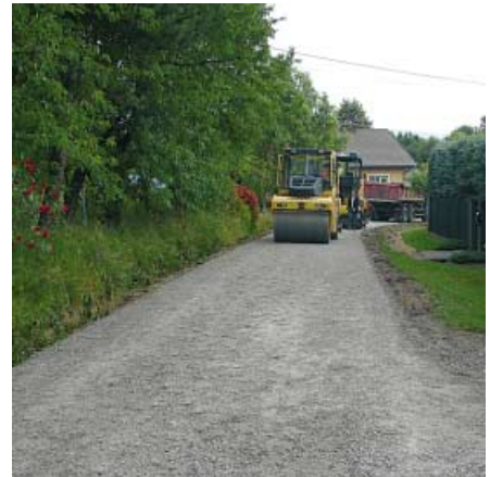
Droga Turza - Zalesie układanie podbudowy
